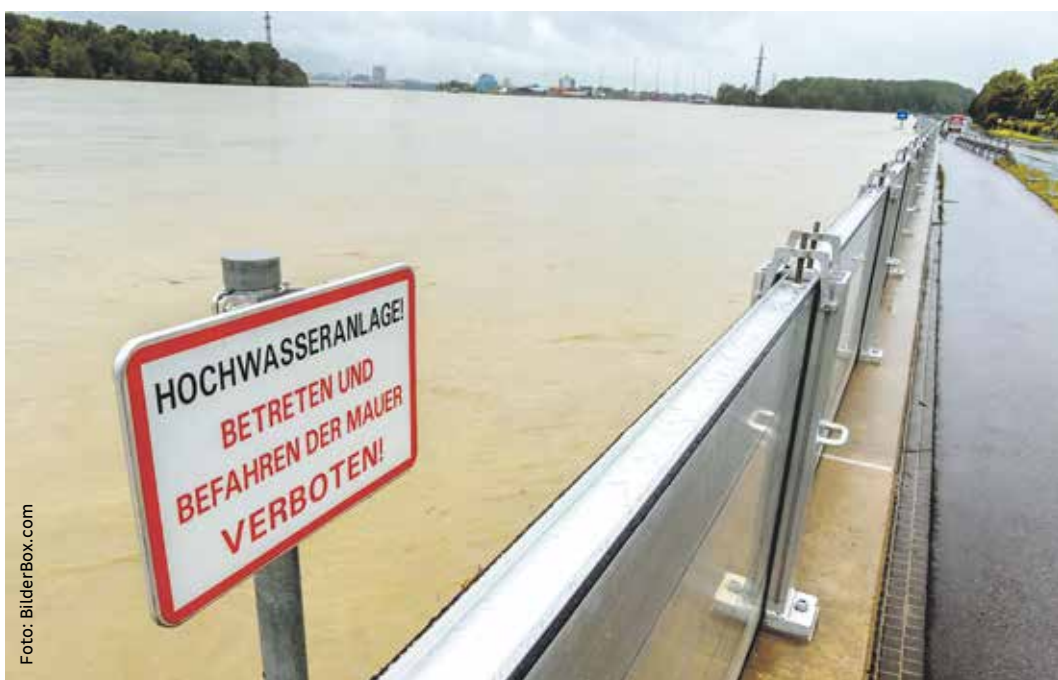
Beim Hochwasser 2013 im oberösterreichischen Mauthausen kam an der Donau der mobile Hochwasserschutz zum Einsatz.
