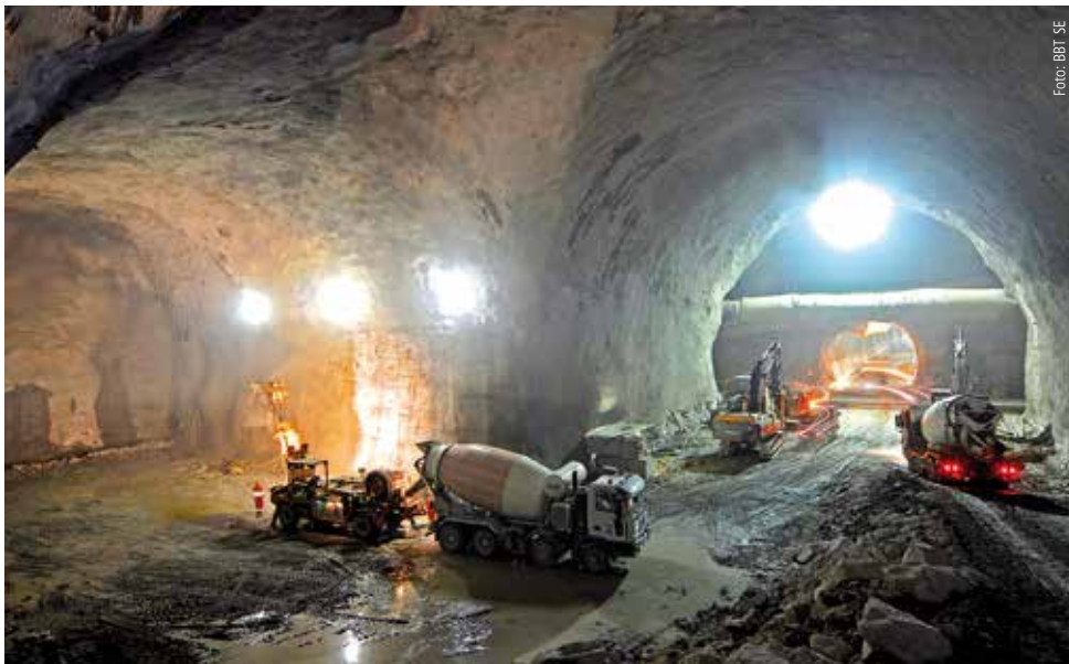
Die ersten Kilometer des Brenner Basis-Haupttunnels in Mauts I primi chilometri della galleria principale del Tunnel di Base del Brennero a Mules
