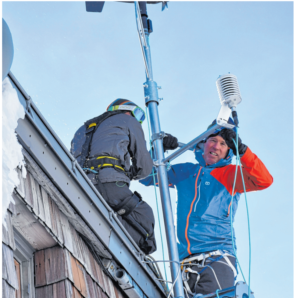
Am Dach der Erzherzog-Johann-Hütte wurde die Wetterstation montiert.
