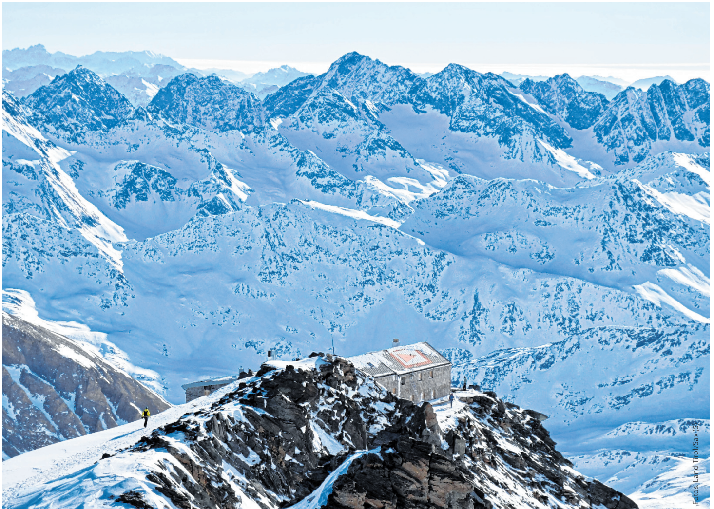
Eingebettet in ein beeindruckendes Bergpanorama befindet sich die Wetterstation auf dem Dach der Schutzhütte.
