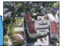
BKH LIENZ Generalsanierung in Umsetzung
