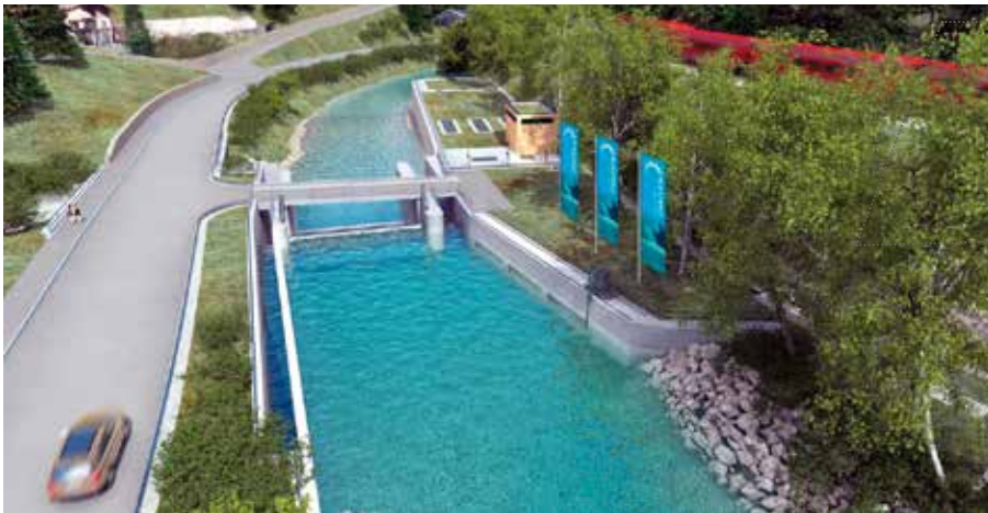
Ein umweltfreundliches Laufkraftwerk im Stanzertal entsteht an der Rosanna im Gemeindegebiet von Stengen am Arlberg.
