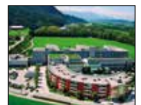
BRH KUFSTEIN Ambulanz- und Funkti- onstrakt in Umsetzung, Erweiterungsbau in Planung
