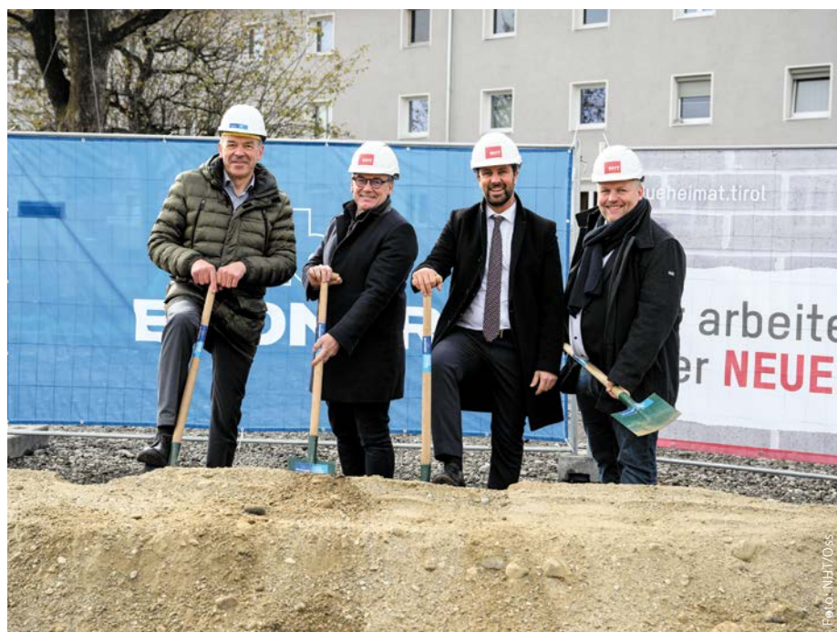
Spatenstich für die nächste NHT-Großbaustelle mit (von li.) Bürgermeister Georg Willi, NHT-Geschäftsführer Markus Pollo, LHStv und Wohnbaulandesrat Georg Dornauer und NHT-Aufsichtsratsvizevorsitzender Lucas Krackl.
